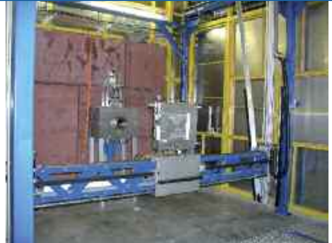
ALTERNATIV KANN AUCH EIN GAS-DRAHT-DETEKTOR (DENEX) VERWENDET WERDEN. DIE HIER GEZEIGTE POSITION IST CA. 10 M VOM PROBENORT ENTFERNT. ALTERNATIVELY, A DENEX MULTI-WIRE DETECTOR CAN ALSO BE USED. HERE, IT IS POSITIONED APPROXIMATELY 10 METRES FROM THE SAMPLE.
